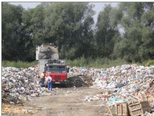
Slika 16. Odlaganje na odlagalištu "Ori" Izvor: Arhiva Zavoda za prostorno uređenje KKŽ, 2012.
